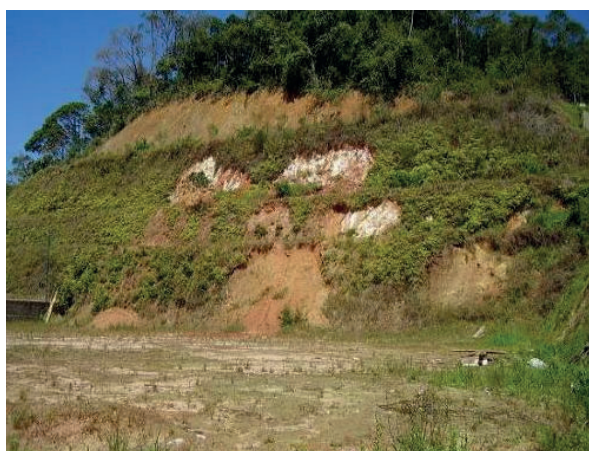
Figura 2 – Foto do talude
