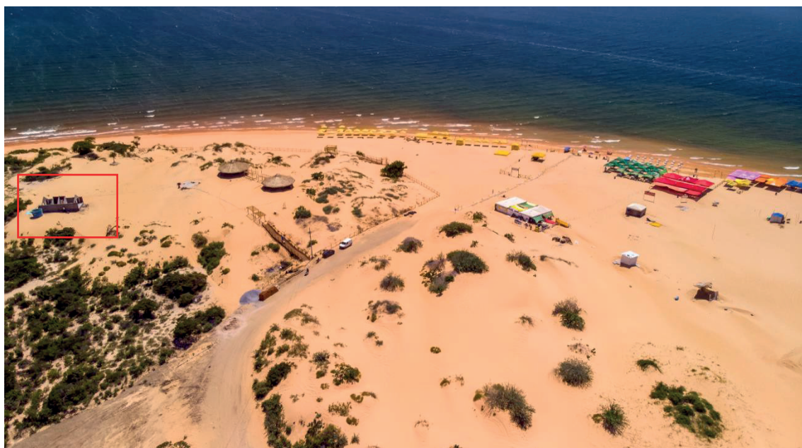
Figura 16 – Vista de edificações irregulares
